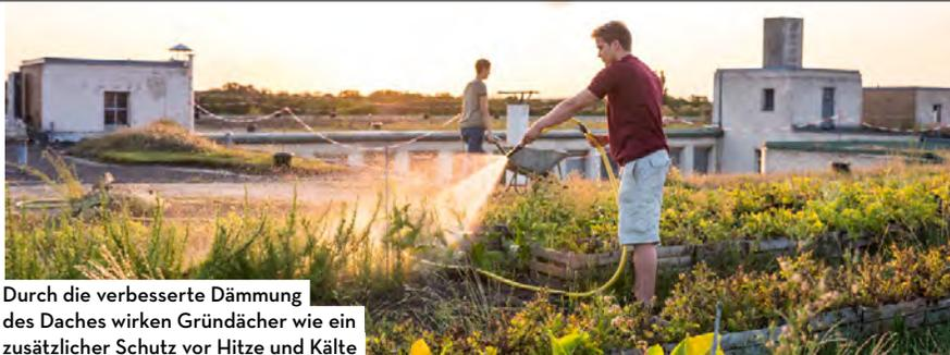
Durch die verbesserte Dämmung des Daches wirken Gründächer wie ein zusätzlicher Schutz vor Hitze und Kälte
