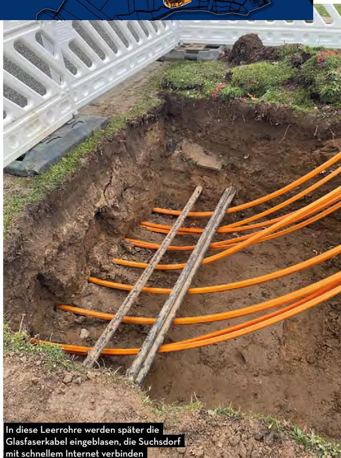
In diese Leerrohre werden später die Glasfaserkabel eingeblasen, die Suchsdorf mit schnellem Internet verbinden
